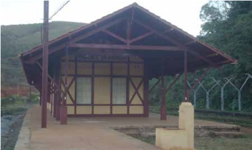
Figura 6 – Estação Ferroviária de Miguel Burnier
