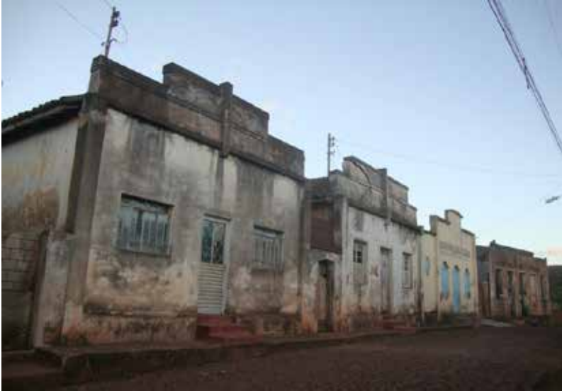
Figura 9 – Entorno da linha férrea, próximo à Estação de Miguel Burnier
