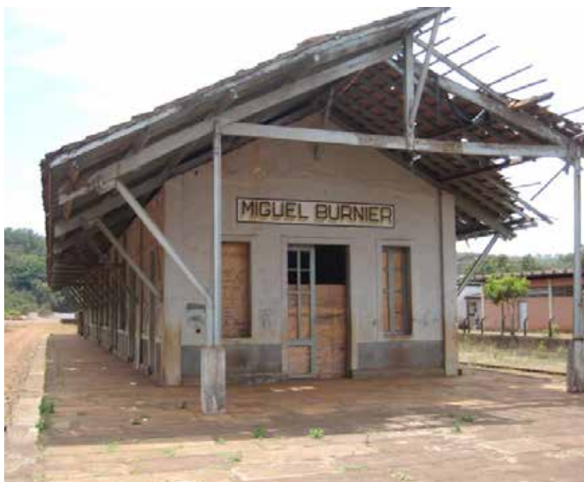
Figura 5 – Estação Ferroviária de Miguel Burnier
