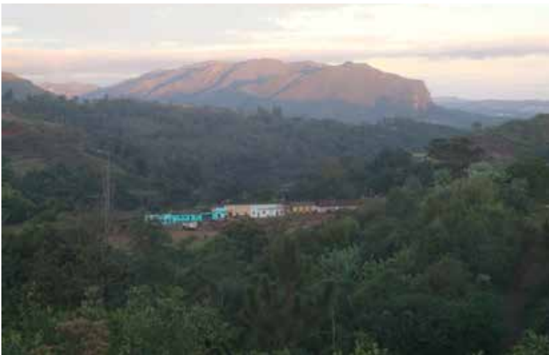
Figura 10 – Vista panorâmica do entorno da Estação Ferroviária
