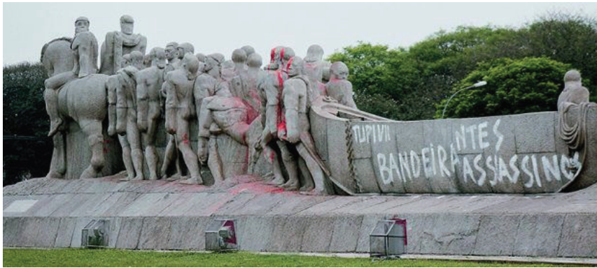
Figura 3 – Pichação no Monumento às Bandeiras, em São Paulo
